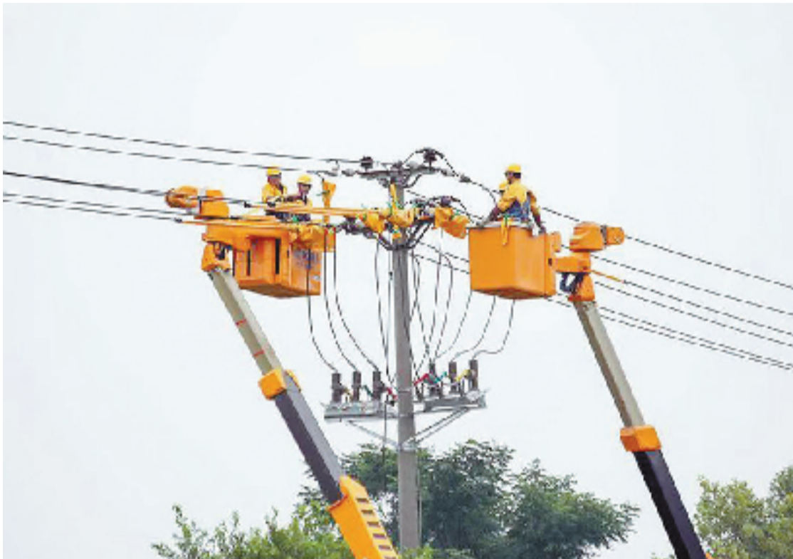
国网电力检修中
