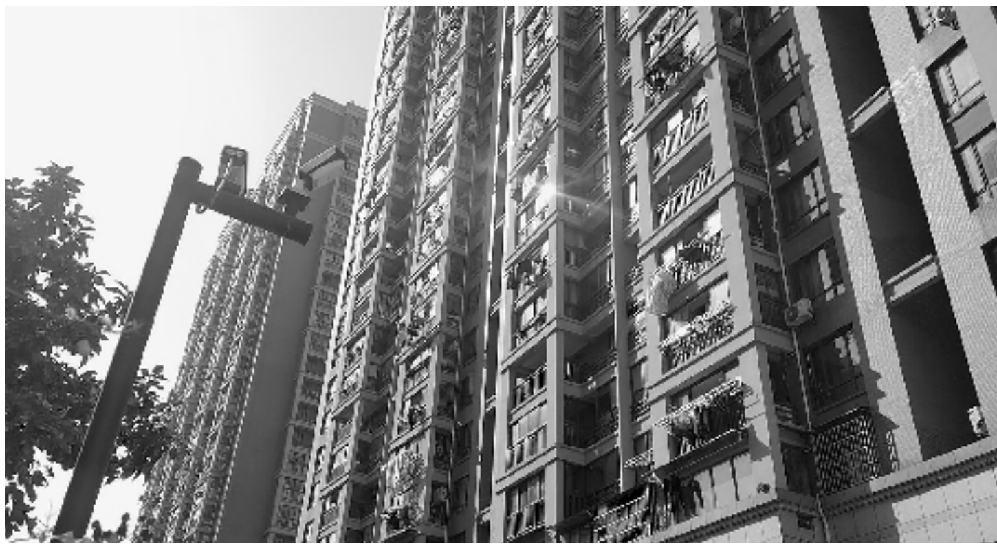
萧山一小区安装22只防高空抛物监控,效果显著。 本报记者 章然 摄
