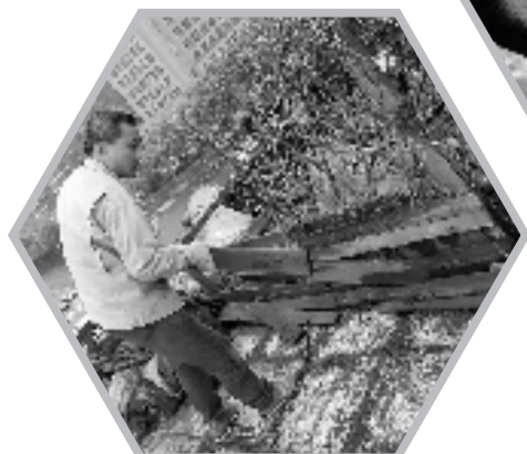
清理楼顶垃圾
