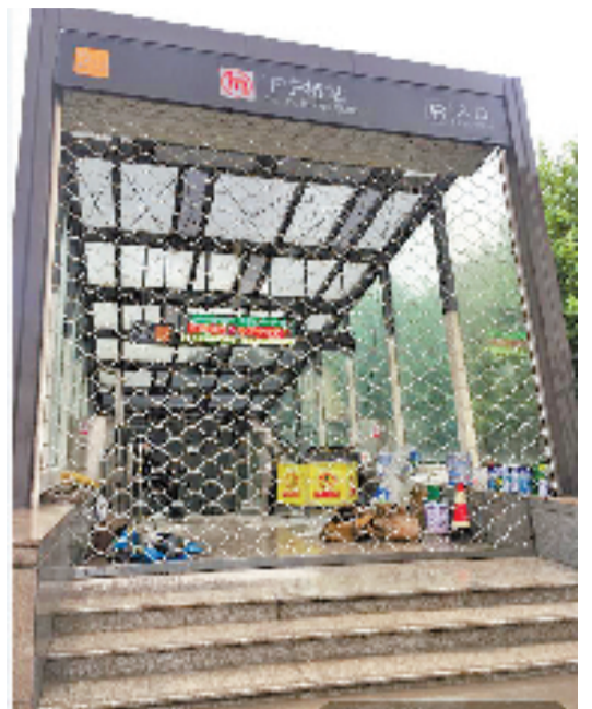
地铁2号线下宁桥站B口
