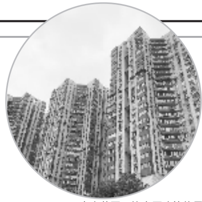
中山花园三栋大厦建筑体量庞大
