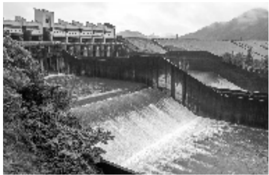
青山水库开启10孔闸门全力泄洪,下泄流量达140立方米/秒。 本报记者 董旭明 摄
