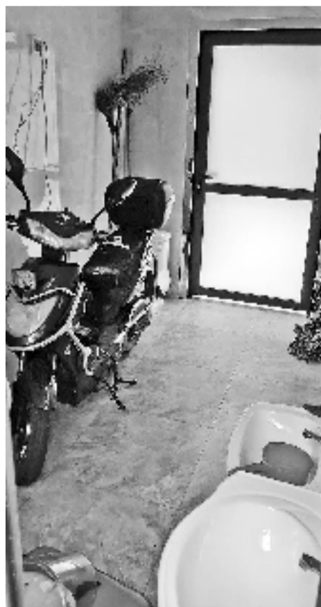
第三卫生间总体布局不合理
