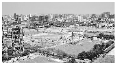
建设中的始版桥未来社区
