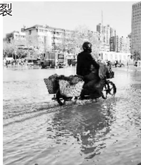
文晖路建国路口水管爆裂
