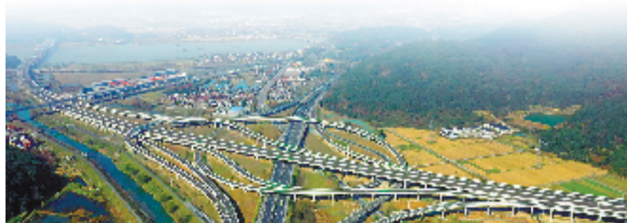
俯瞰杭州绕城西复线中埠枢纽。记者 董旭明 摄
