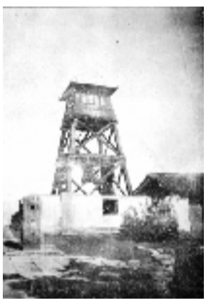
解放初期的瞭望塔
