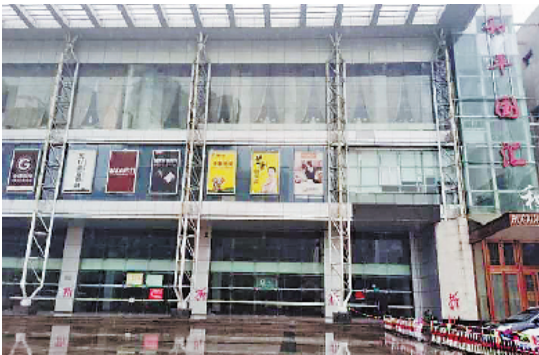
即将被拆除的和平会展中心
