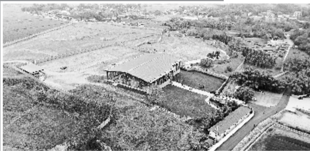
俯瞰三星堆考古大棚 视觉中国供图
