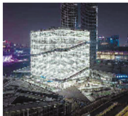
综合训练馆夜景
