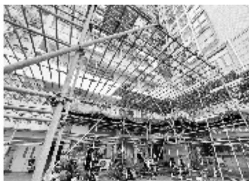
经搭建到2层楼的位置。工人们正在用竹板一点填满脚手架缝隙。
