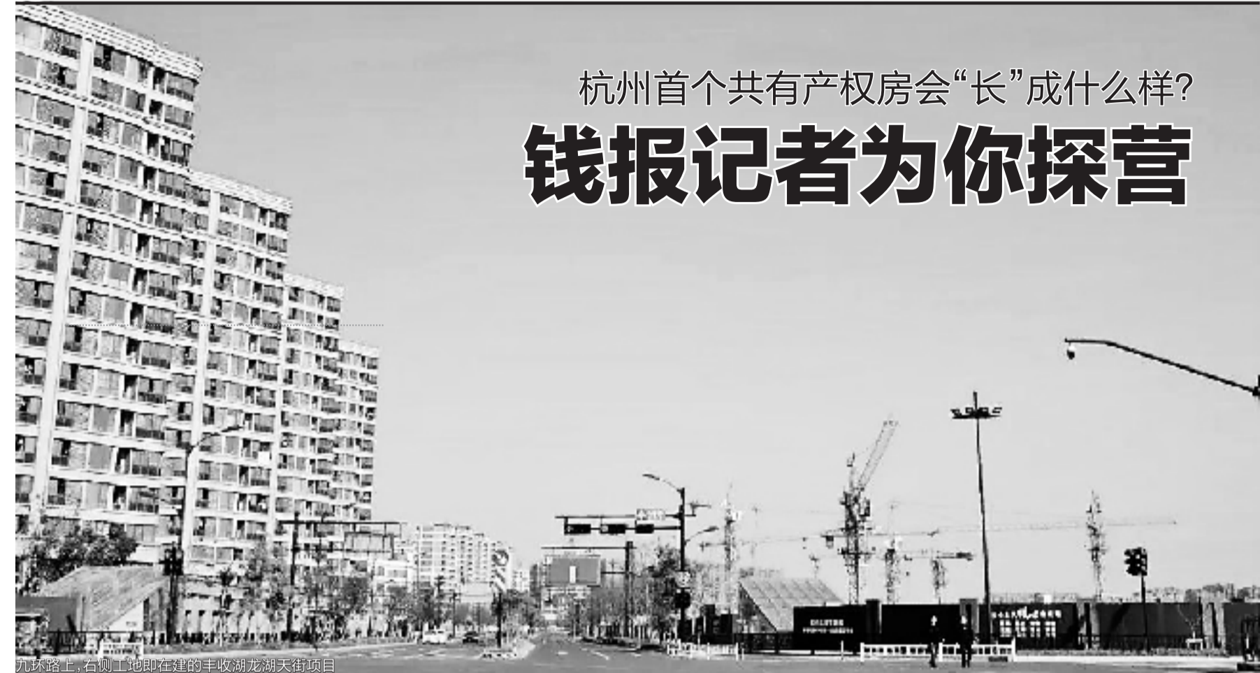
九环路上,右侧工地即在建的丰收湖龙湖天街项目
