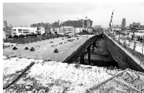
杭州莫干山路提升改造工程主线高架贯通
