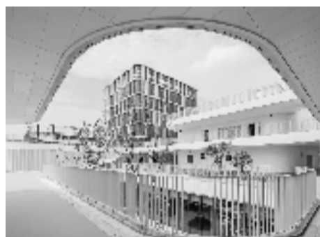
杭州市硅谷小学实景图
