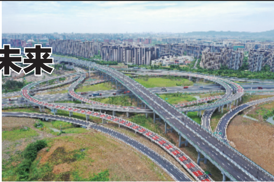
杭州绕城高速公路三墩互通改建工程
