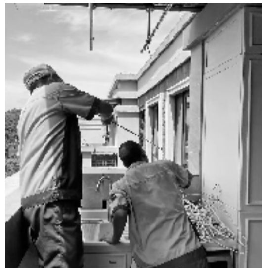
维修人员寻找空调故障原因
