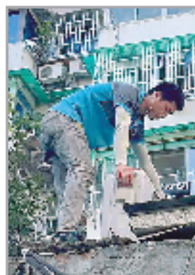
安装空调外机
