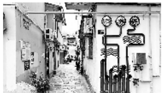
泗水弄燃气管道的布局符合历史街区的韵味
