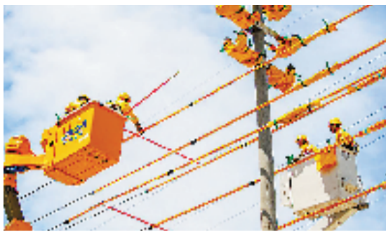
高温下的温岭供电公司带电作业班。好摄之友@李攀璐
