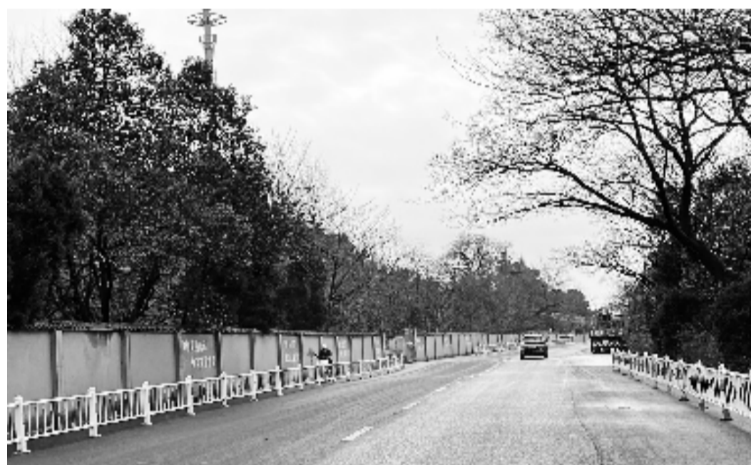
临半路部分路段已铺好了沥青
