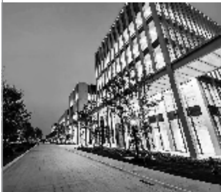
中冶交通承建的 浙江大学杭州国际科创中心一期工程
