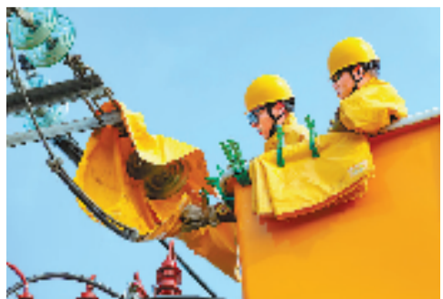
高温下的电力工人 好摄之友@凡尘
