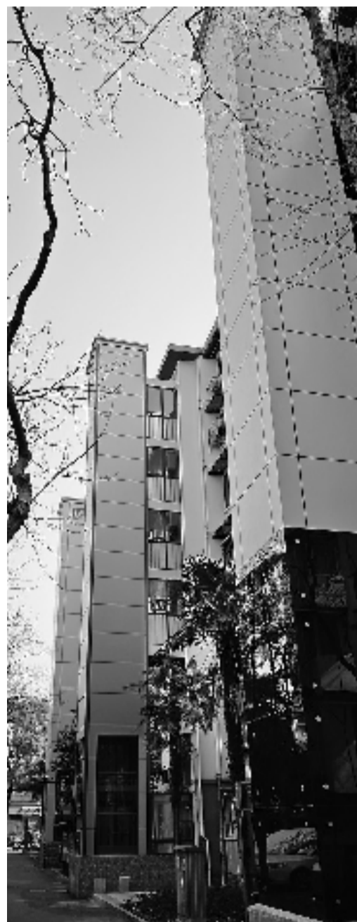
小区里不同品牌的加装电梯
