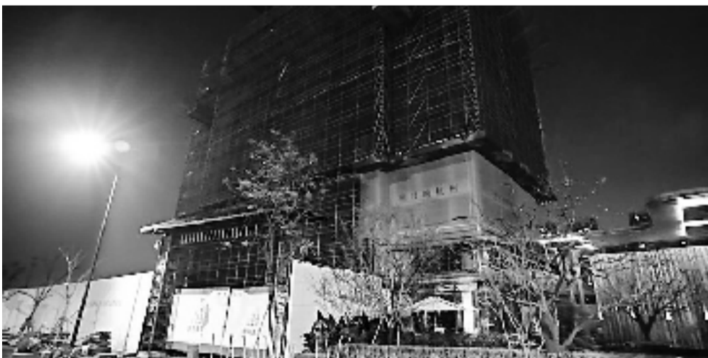
夜间传出噪音的建筑工地 邹宸 摄
