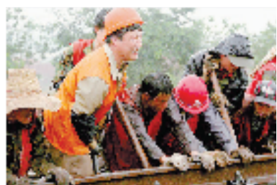
21世纪初期浙赣线电气化改造驳接施工 来源:杭州工务段
