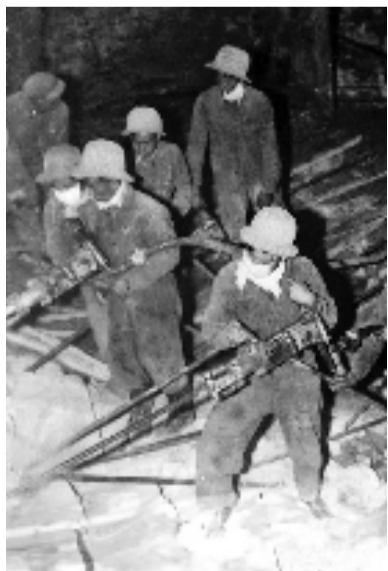
新安江水电站工地上的风钻工 受访者供图
